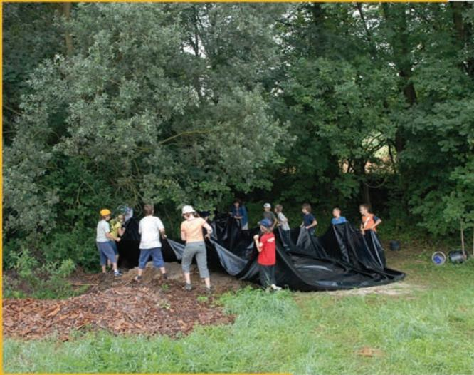
von Spaten und Schaufeln, als auch mit Hilfe eines Baggers hergestellt. Daraufhin musste die Grube mit Spezialfolie abgedeckt werden, damit kein Wasser absickern kann.
